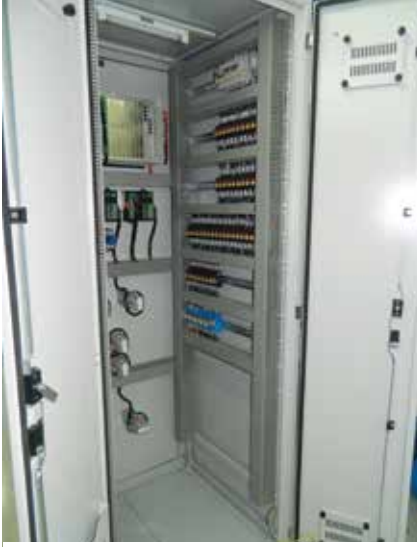
Resim2: 61850 Kontrol Panosu İç Görünüş
