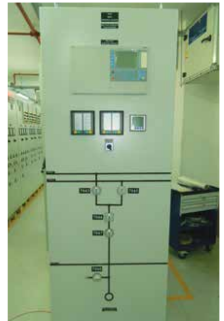
Resim1: 380kV 61850 Kontrol Panosu Ön Görünüş
